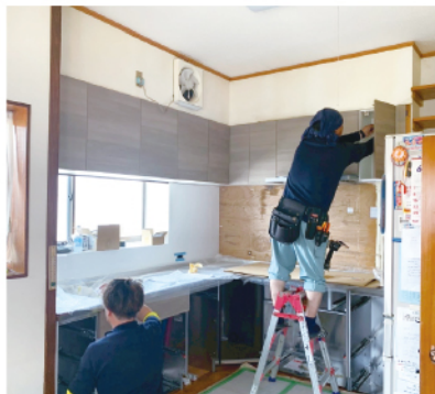
キッチン、お風呂、トイレなど水回りの設備工事ははじめ、地域の快適な暮らしをサポートしている
