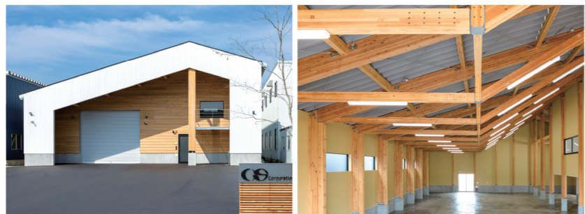
多雪地に建つ事務所兼倉庫。既製品の集成材と金物を主として、鉄骨造の予算と同程度の建設費で木造建築を実現
