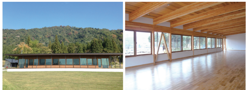
積雪3mの豪雪地帯のレストランは席数120席の大空間。「見せる木の構造」で美しく広がる田園風景を建物に取り込む意匠意図を叶えた
